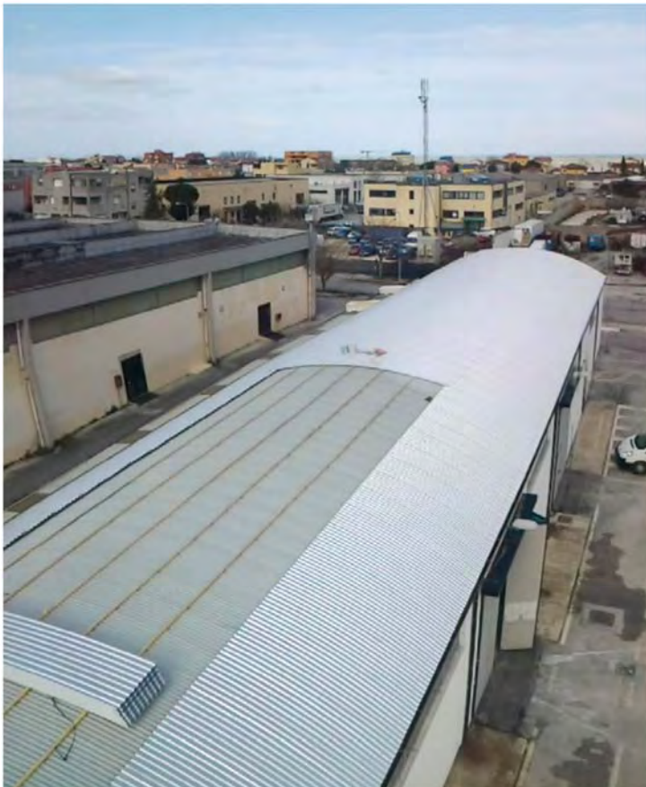
REALIZZAZIONE DI COPERTURA CURVA MEDIANTE TACCHETTATURA DI ITP MONO 28
